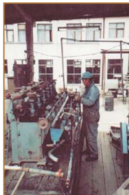
Infraestructura del DMM-Oruro
