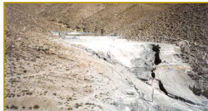
Vista de la Presa de Colas en la Mina Abaroa
