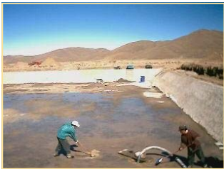
Presas de Colas Laguna Pampa Foto: Marco Prado
