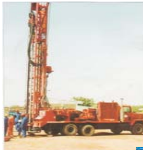
Perforación de Pozo, con un equipo TH-60
